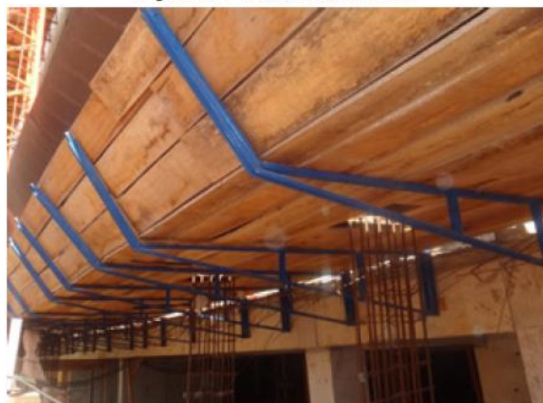
Figura 27 - Plataforma de Madeira
