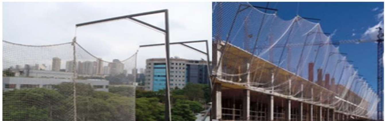
Figura 31 - Estrutura Metálica para a Colocação da Rede de Segurança
