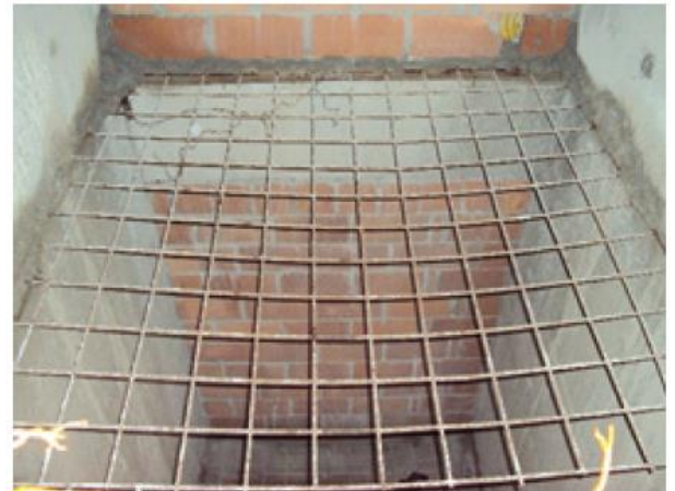
Figura 23 - Primeiro o Fechamento com Tela de Aço
