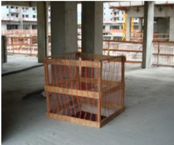
Figura 22 - Fechamento de Aberturas com GcR
