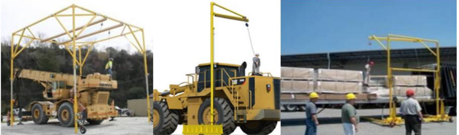
Figura 33 - Estruturas Móveis para Proteção Contra Queda
