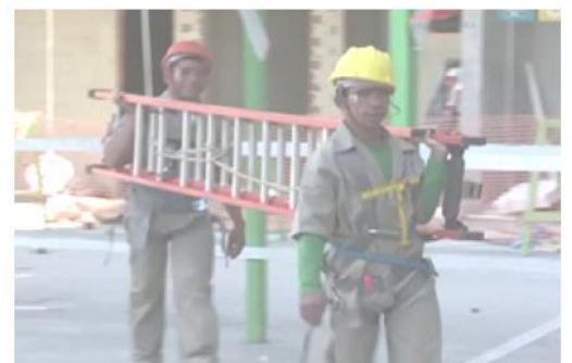
Figura 52 - Transporte de Escada
