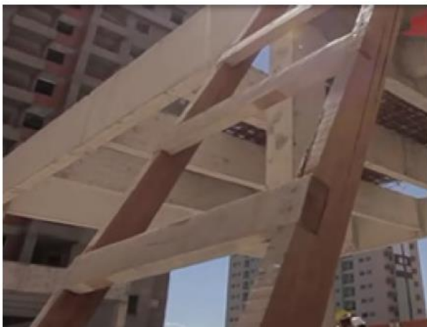
Figura 50 - Montagem de Escada de Mão com Cavilhas
