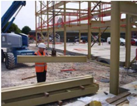
Figura 124 - Técnica de içamento ideal pelo centro de gravidade da peça.
