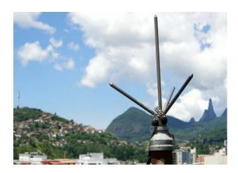
O nível, o tipo e o posicionamento do SPDA precisam ser estudados cuidadosamente no estágio de projeto da edificação, para se tirar o máximo proveito dos elementos condutores da própria estrutura.
